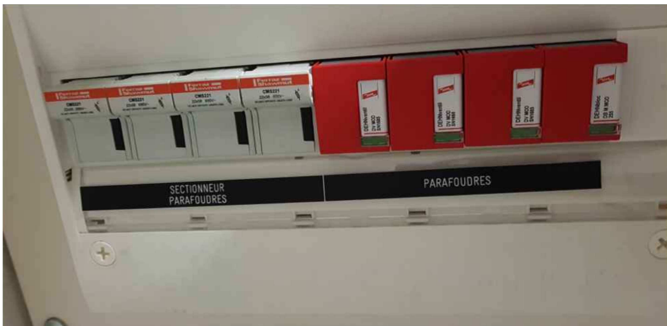
TGBT - Parafoudre de Type 1 avec capot de protection
