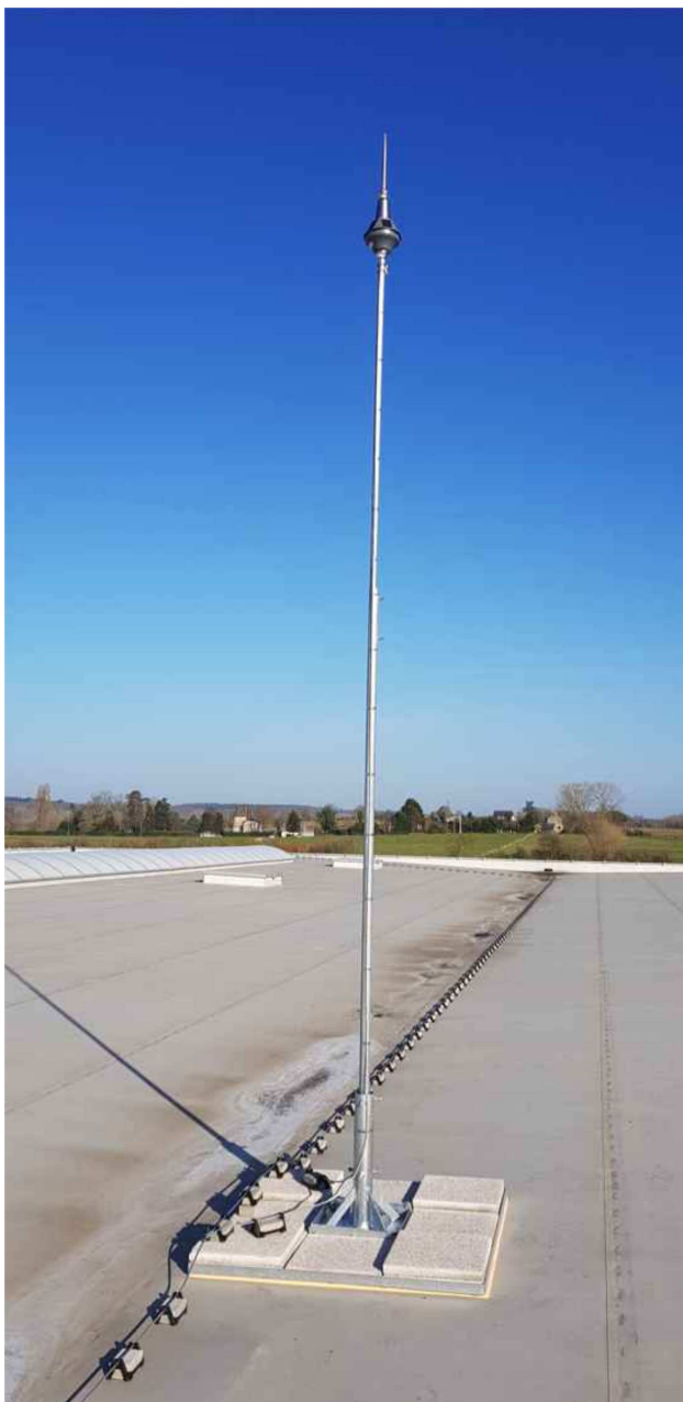
Paratonnerre à dispositif d'amorçage
