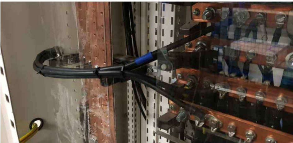
TGBT - Parafoudre de Type 1 – raccordement au jeu de barres
