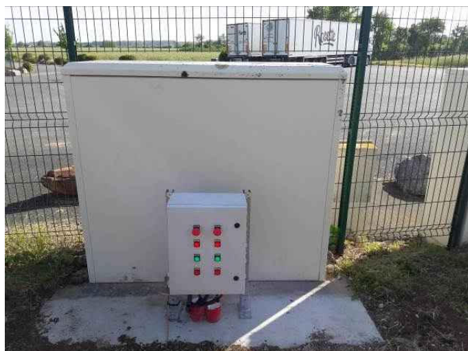
Armoire électrique des vannes et pompes
